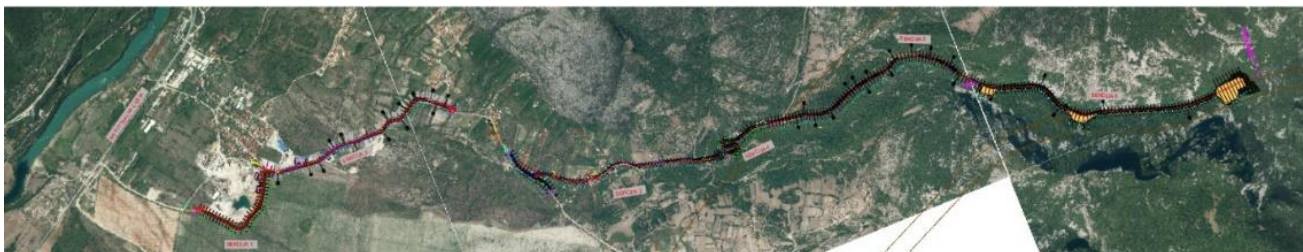
Slika 3-28: Pregled dionica JP1, JP2, JP3, JP4, JP5 i JP6 pristupnog puta tunelu Prenj sa južne strane
