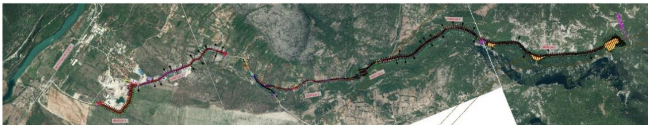
Slika 3-9: Pregled dionica JP1, JP2, JP3, JP4, JP5 i JP6 pristupnog puta tunelu Prenj sa južne strane
