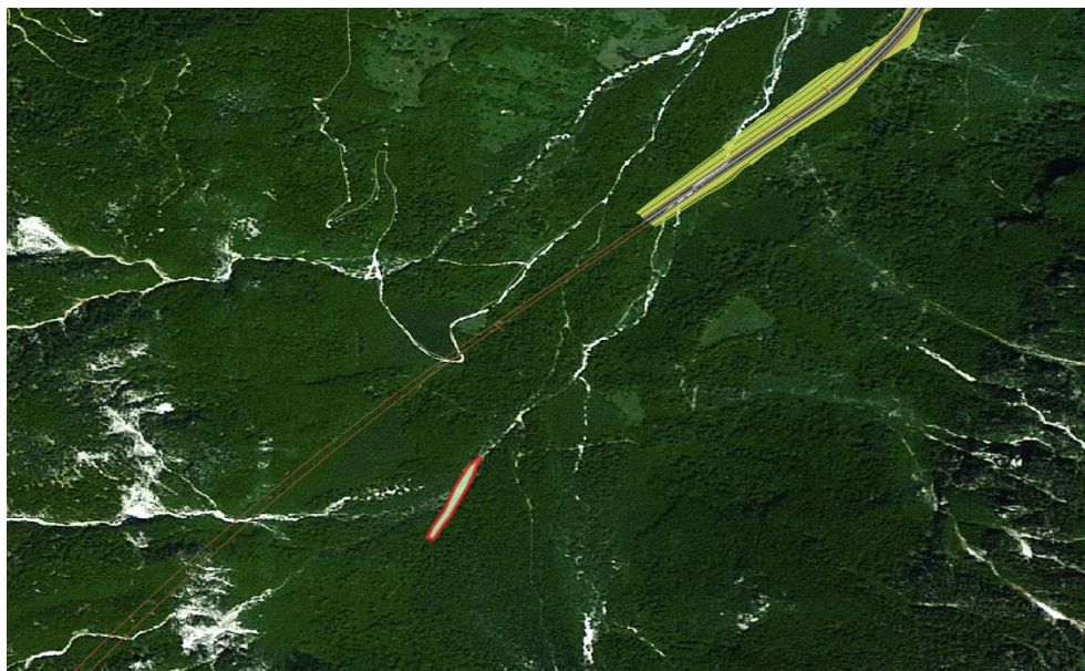
Slika 1: EAAA stanišnog tipa 3240 Obale alpijskih rijeka obrasle zajednicama sive vrbe Salix eleagnos u odnosu na sjeverni ulaz tunela Prenj
