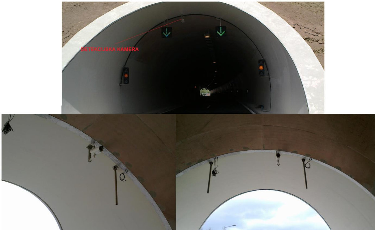
Sl. 7 – Položaj i način montaže detekcijskih kamera
