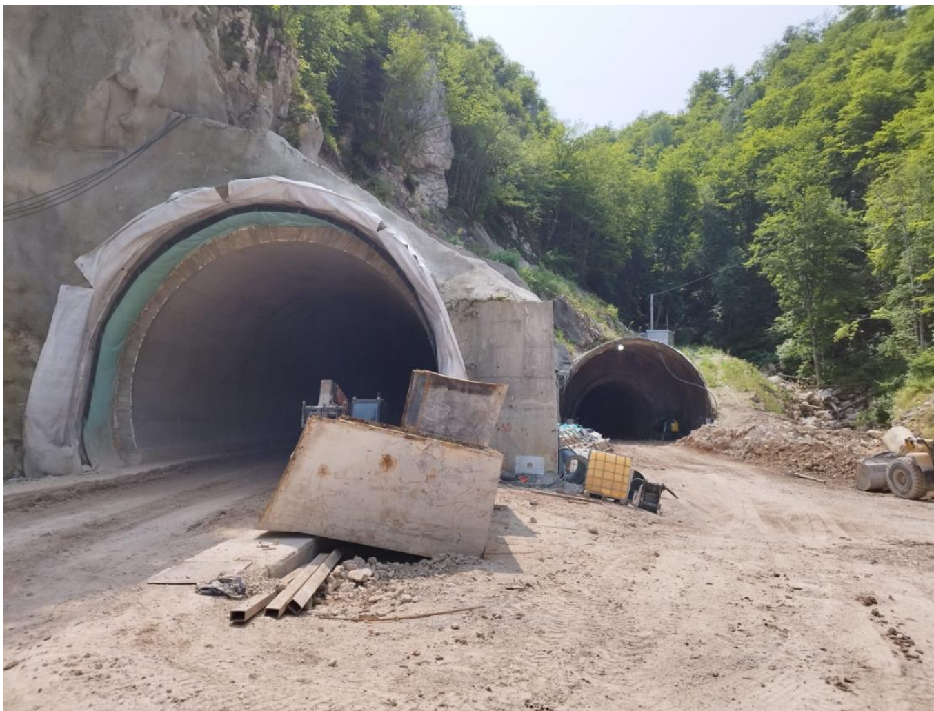
Slika br.1: Tunel Hranjen
