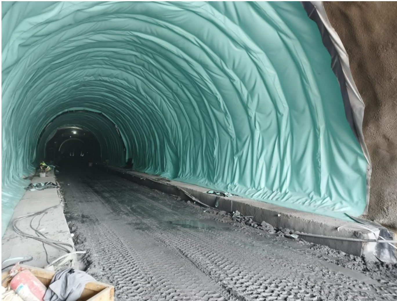
Slika br.2: Tunel Hranjen
