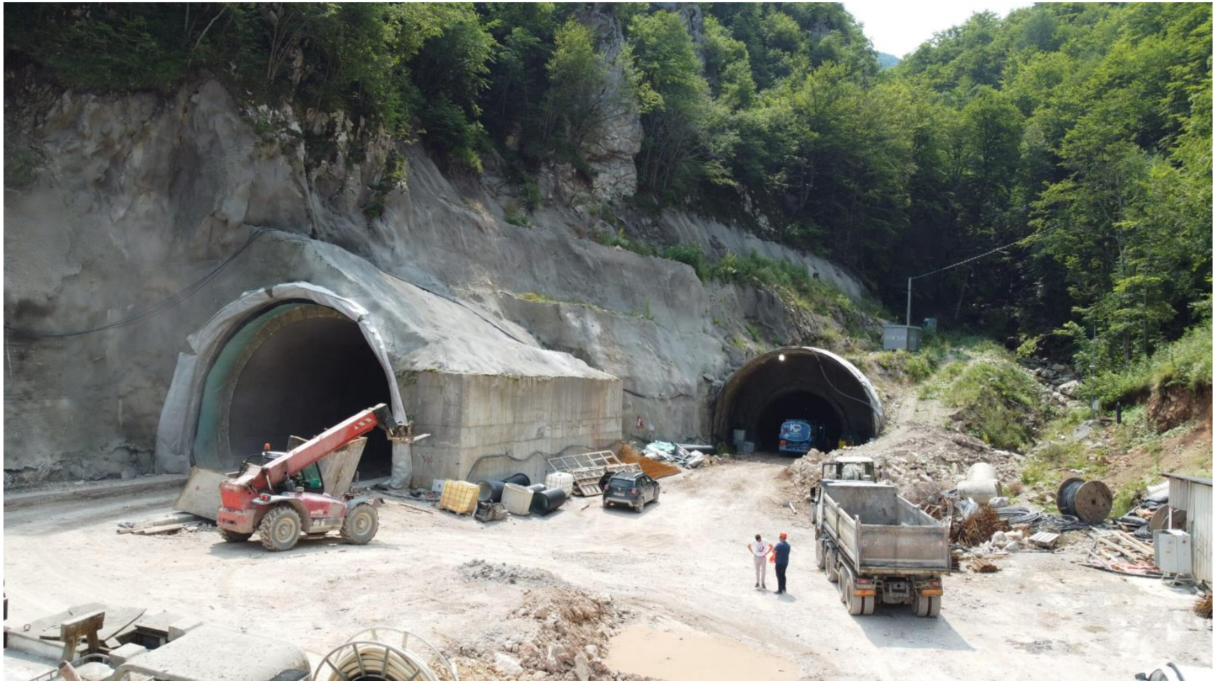
Slika br.3: Tunel Hranjen
