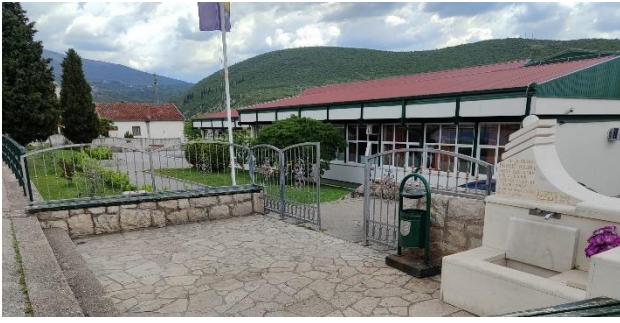
Slika 11 Ulaz Osnovne škole u Blagaju
