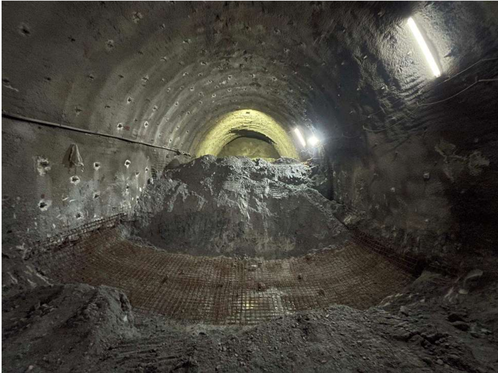
Slika br. 3: Tunel Hranjen - radovi na iskupu i podgrađivanju podnožnog svoda glavne tunelske cijevi - sjever
