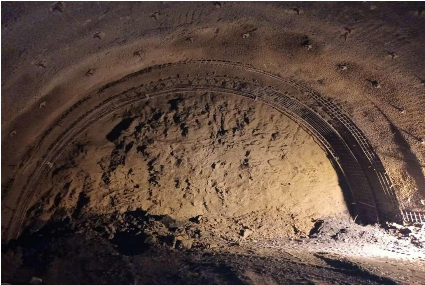
Slika br. 1: Tunel Hranjen - radovi na iskopu i podgrađivanju kalote glavne tunelske cijevi - jug čelo na km 5+998,05
