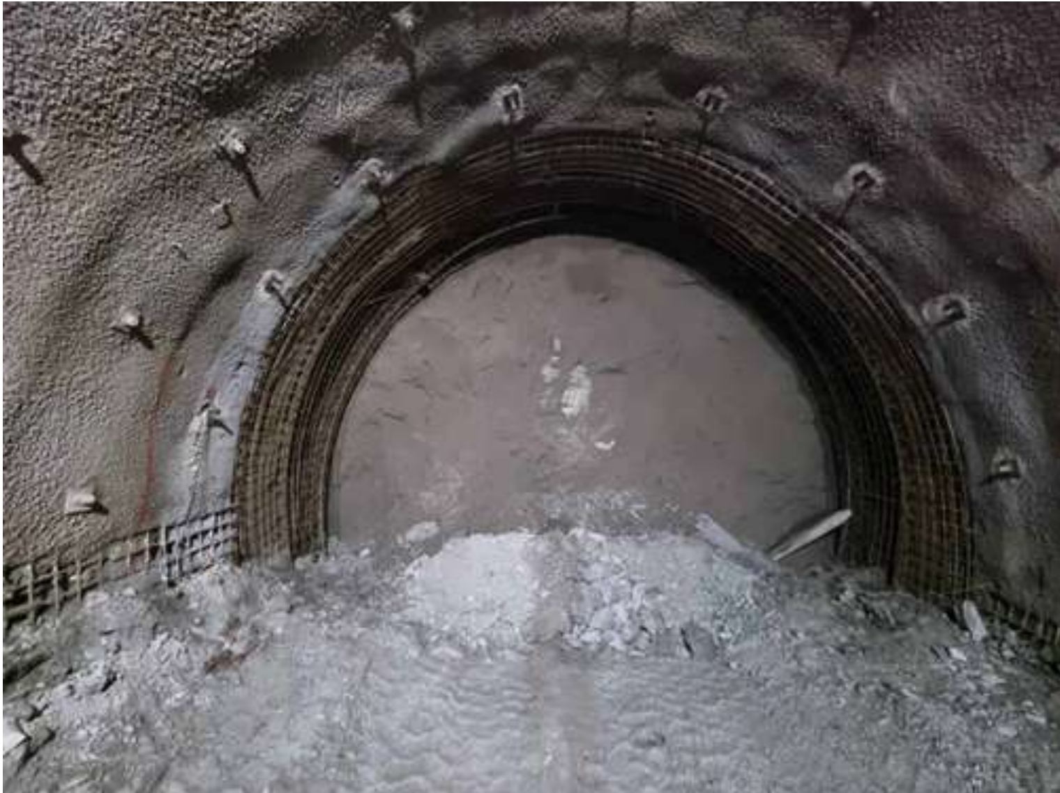
Slika br. 4: Tunel Hranjen - radovi na iskupu i prilagođavanju kalotne servisne cijevi - sjever
