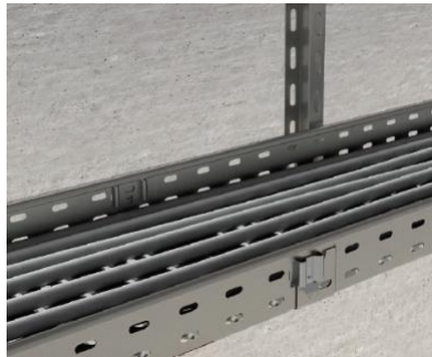
a. na stropu tunela
