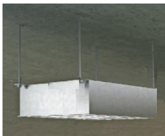
a. Montaža svjetiljki osnovnog osvjetljenja
