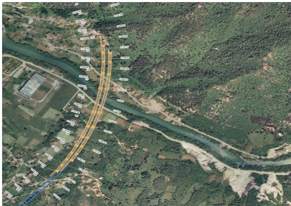
Slika 12-34: Vibracijsko žarište #2 – vijadukt 3 i južni portal tunela T-1
