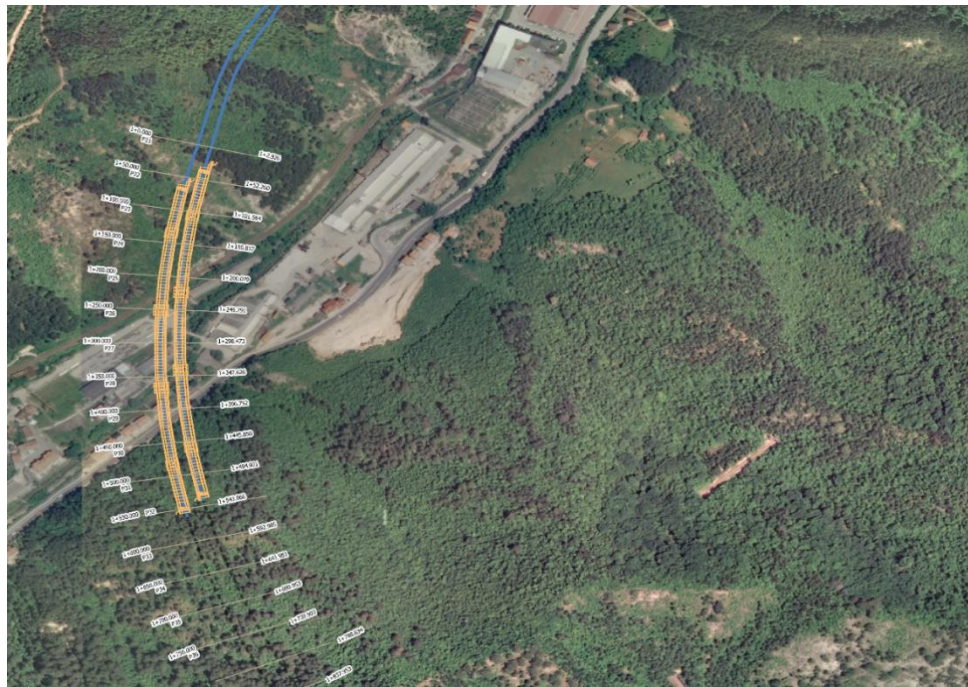
Slika 12-33: Vibracijsko žarište #1 – vijadukt 2 i sjeverni portal tunela T-1
