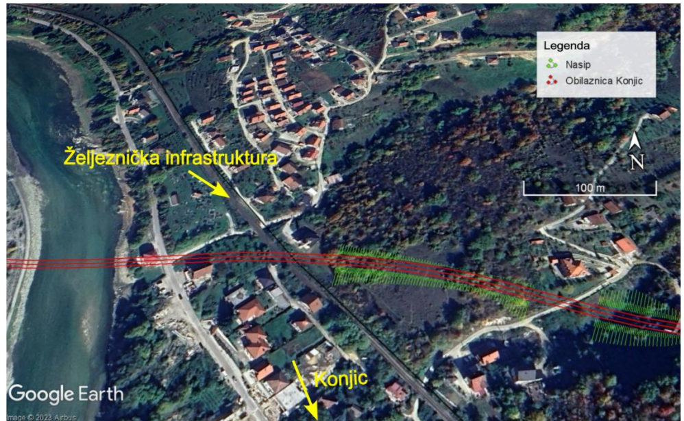
Slika 16-10: Željeznička infrastruktura presječena vijaduktom u naselju Donje Selo
