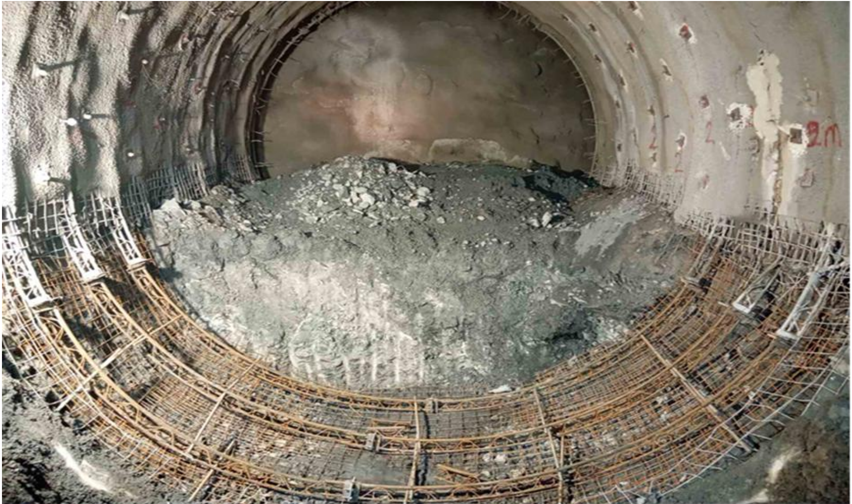
Slika br. 2 – Radovi na iskopu i podgrađivanju podnožnog svoda servisne tunelske cijevi jug
