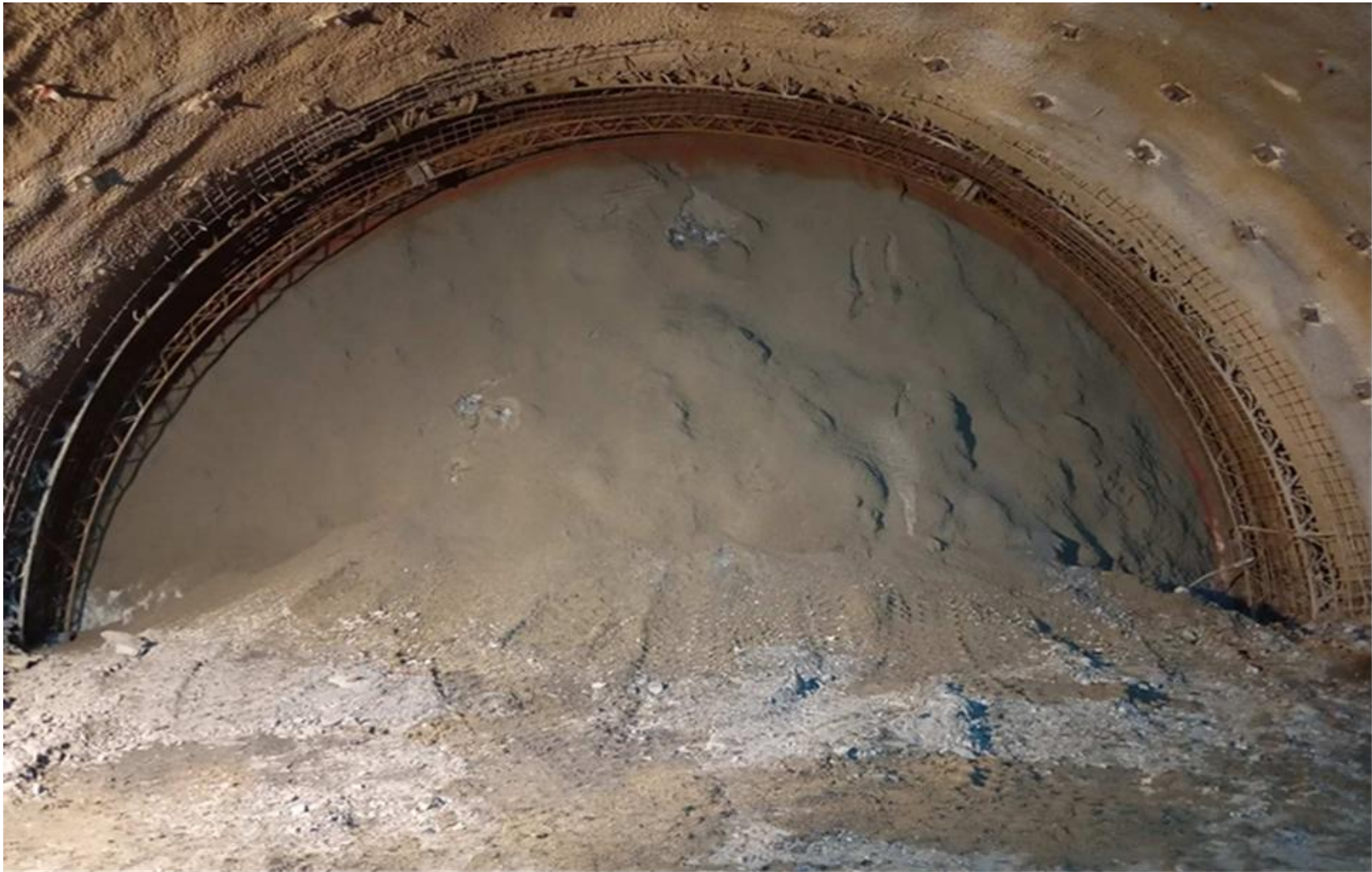
Slika br. 1 – Radovi na iskopu i podgrađivanju kalote glavne tunelske cijevi – jug
