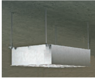
a. Montaža svjetiljki osnovnog osvjetljenja
