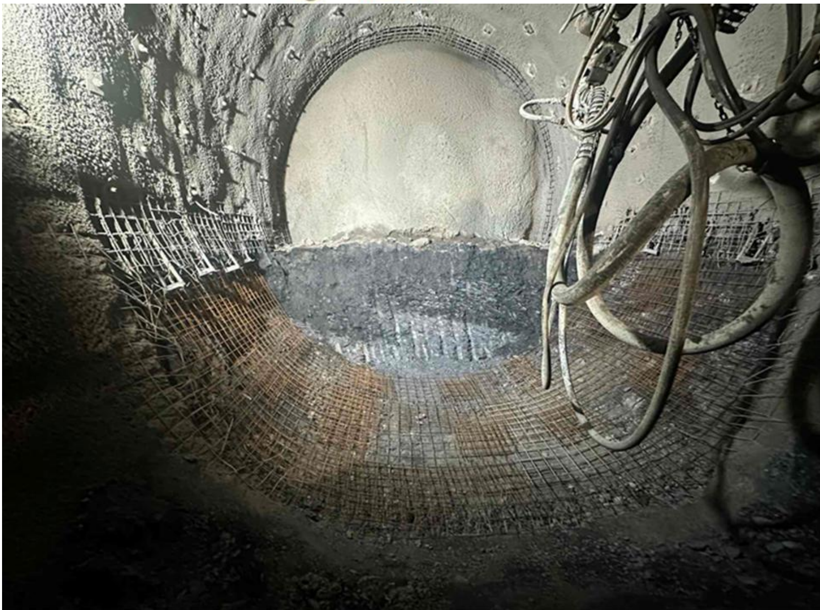
Slika br. 3 – Radovi na iskopu i podgrađivanju kalote i stepenice servisne tunelske cijevi - sjever (Tunel Hranjen)
