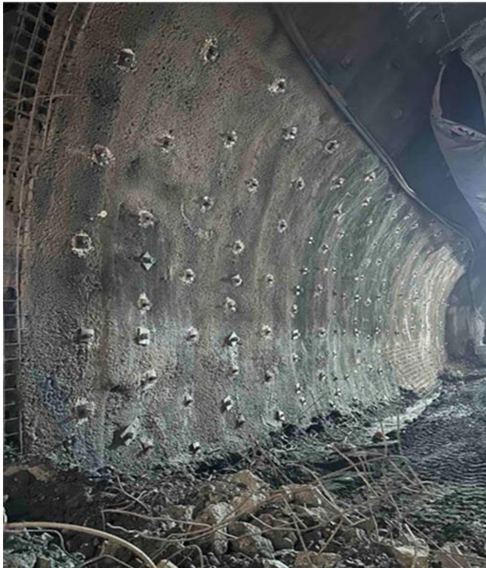
Slika br. 1 – Radovi na sanaciji podgrade glavne tunelske cijevi – jug (Tunel Hranjen)
