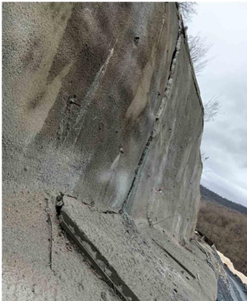
Slika br. 2 – Oštećenje lijeve kosine južnog predusjeka (Tunel Hranjen)
