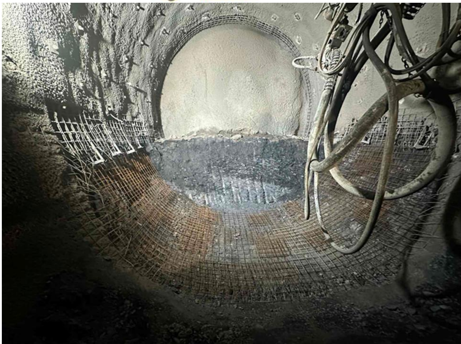
Slika br. 3 – Radovi na iskupu i podgrađivanju kalote i stepenice servisne tunelske cijevi - sjever (Tunel Hranjen)
